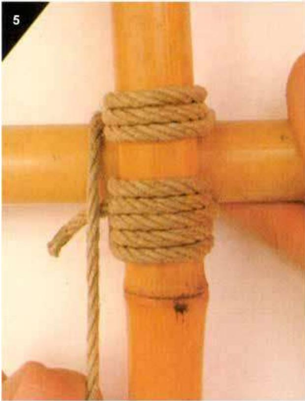
**ÉTAPE CINQ.** APRÈS AVOIR DÉPASSÉ LA DEMI-CLÉ À CAPELER, FAIRE PASSER ET SERRER LA CORDE AUTOUR DE LA PERCHE HORIZONTALE EN PARTANT DE L'ARRIÈRE ET COMMENCER À L'ENROULER AUTOUR DES DEUX CÔTÉS DE LA PERCHE. CES ENROULEMENTS SONT APPELÉS DES BRIDURES.
